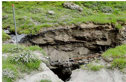
*Noch während das Wasser abfließt, zeigen sich die Schäden an der freigelegten Wasserleitung.*
