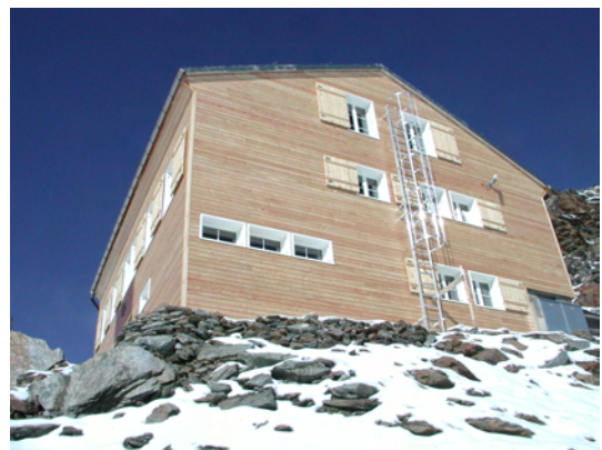
Hütte mit neuen Fenstern, Fluchtleitern und neuer Lärchenschalung
