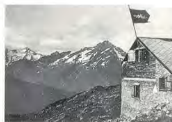
Die Windgällenhütte nach dem Wiederaufbau
